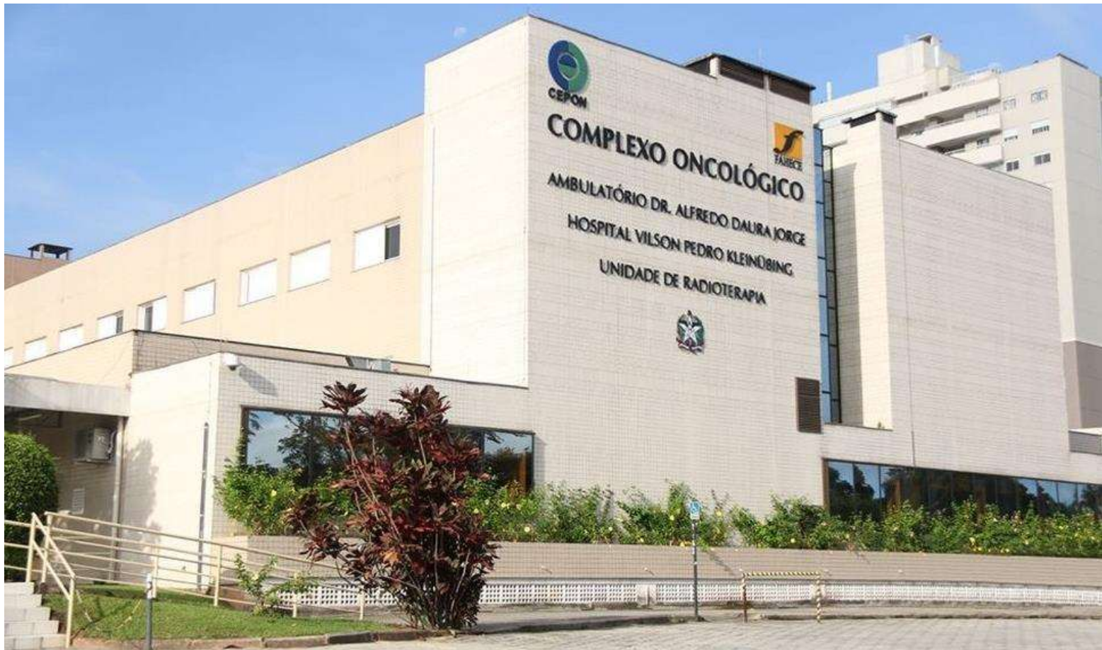
Figura 03 Hospital especializado em oncologia, de grande porte (CEPON), em Florianópolis/SC. Fonte: Prefeitura de Florianópolis.
